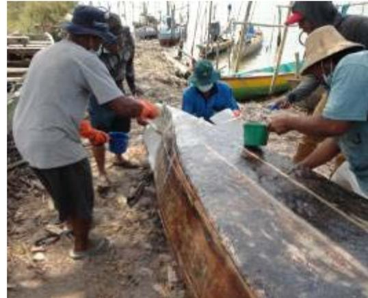
Gambar 4. Pelapisan serat fiberglass pada lambung kapal
