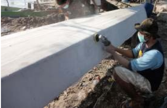
Gambar 6. Pendempulan dan penghalusan
